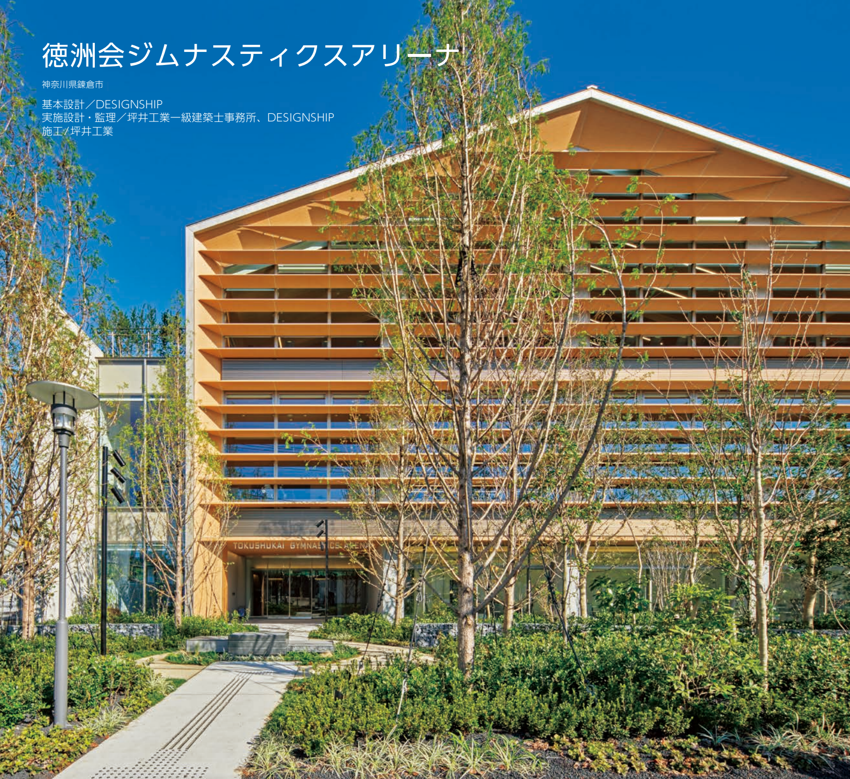
エントランスアプローチより南側外観を見る ルーバーは外装焼付アートテックアルミパネル
